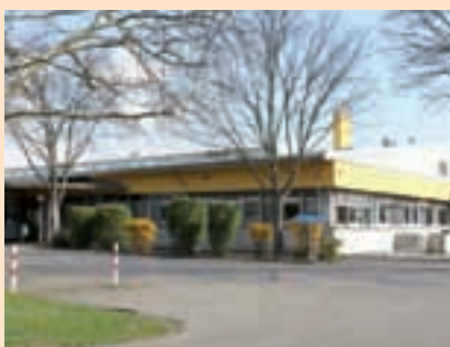
Standort Hagenauer Straße mit neuem Dach, Heizung, BHKW und Lüftungsanlage
